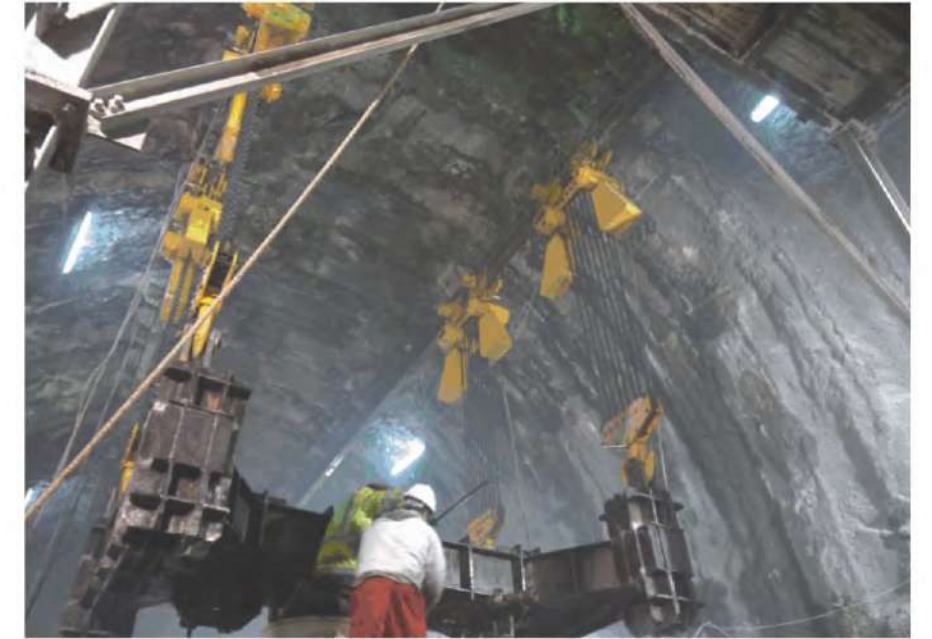
世界500强-意大利CMC100t工程 Fortune 500-ITA CMC 100t Project
