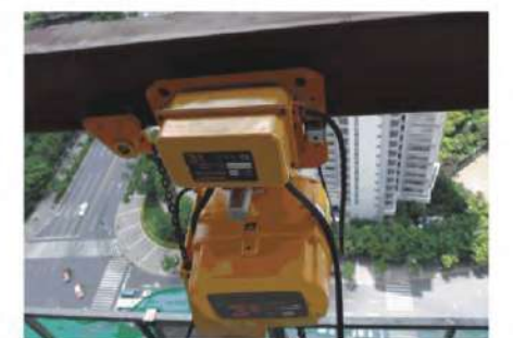
上海建工90米高度起升工程 SCG-90m Lifting Project
